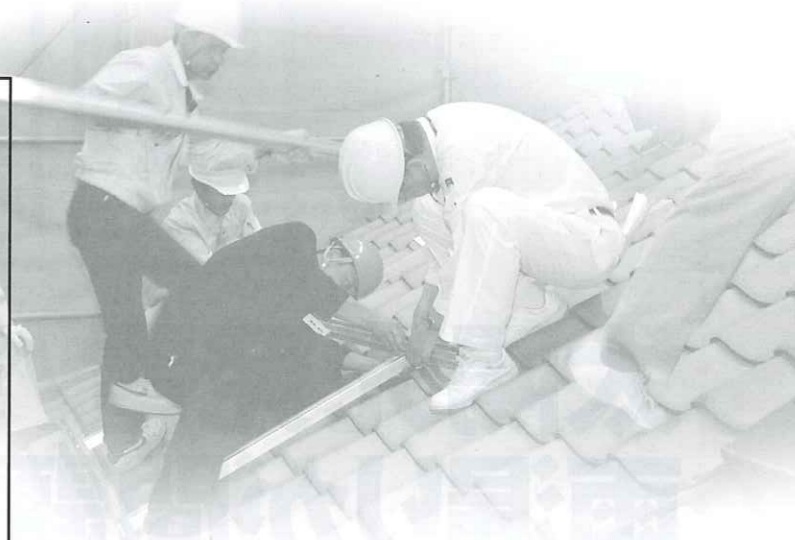
日本PVプランナー育成協会が新設した太陽光発電パネルの施工教育施設の様子。施工トラブル予防のため、実務者を教育(関連記事:2ページ)
